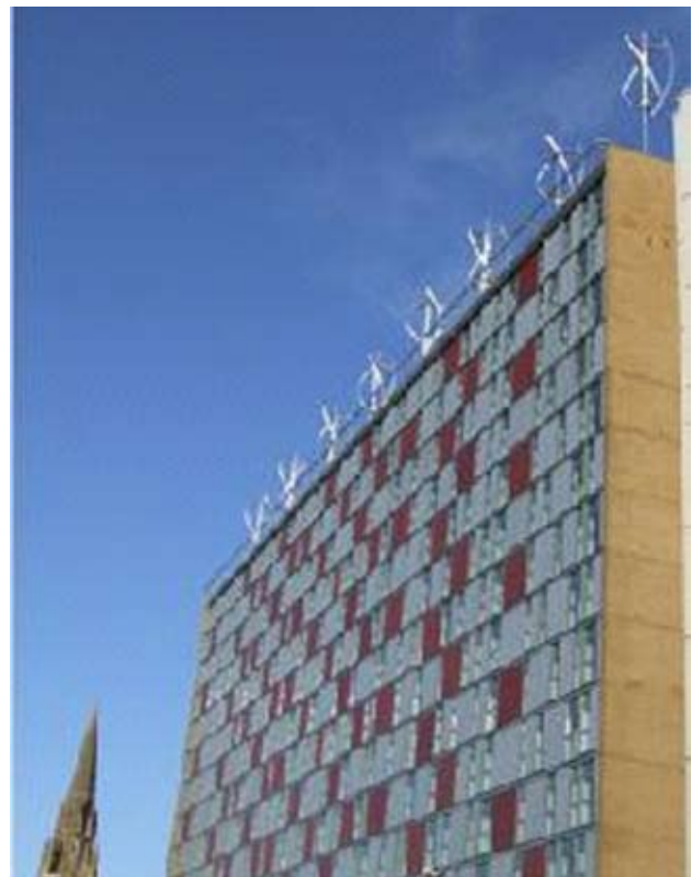
QuietRevolution vindturbiner på leilighetskompleks i London Road. Kilde: www.quietrevolution.co.uk
