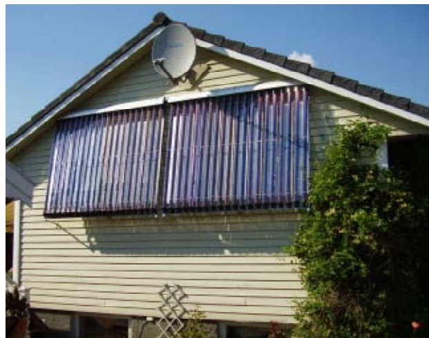
Veggmontert vakuumrør-solfanger. Kilde: www.natur-energi.no
