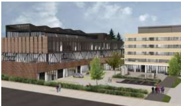
Etterstad vgs, solceller på tak
