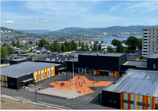
Vinner av Årets lokale klimatililtak 2020: Drammen kommune for "Geotermos - Sommervarme til vinterbruk".
