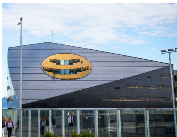
Powerhouse Brattørkaia i Trondheim. Foto: Caroline Dokken Wendelborg
