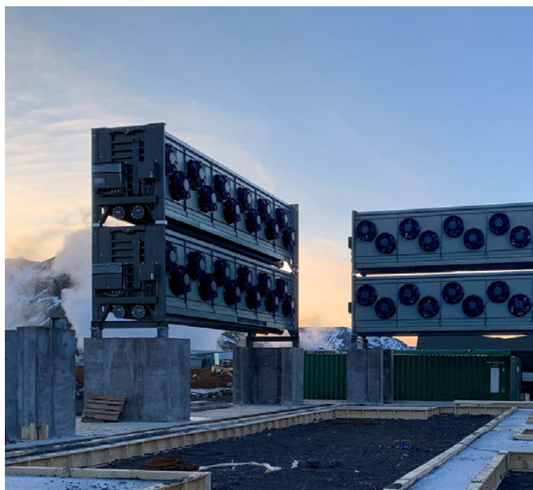
Climeworks sitt CO 2 -fangstanlegg på Island. Foto: Climeworks AG
