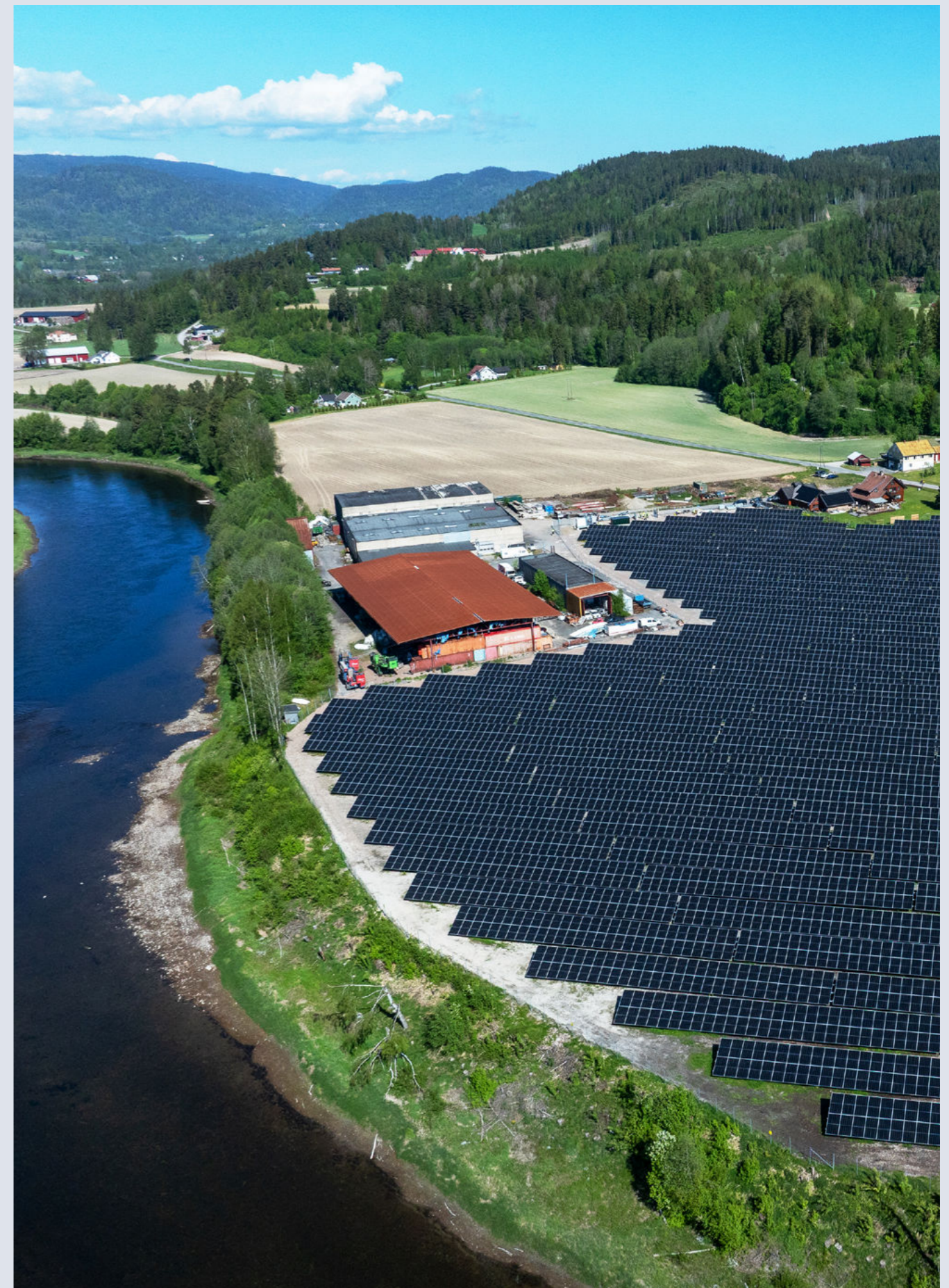
Engene Solkraftverk. Foto: Kjell Løyland/Skagerak Energi
