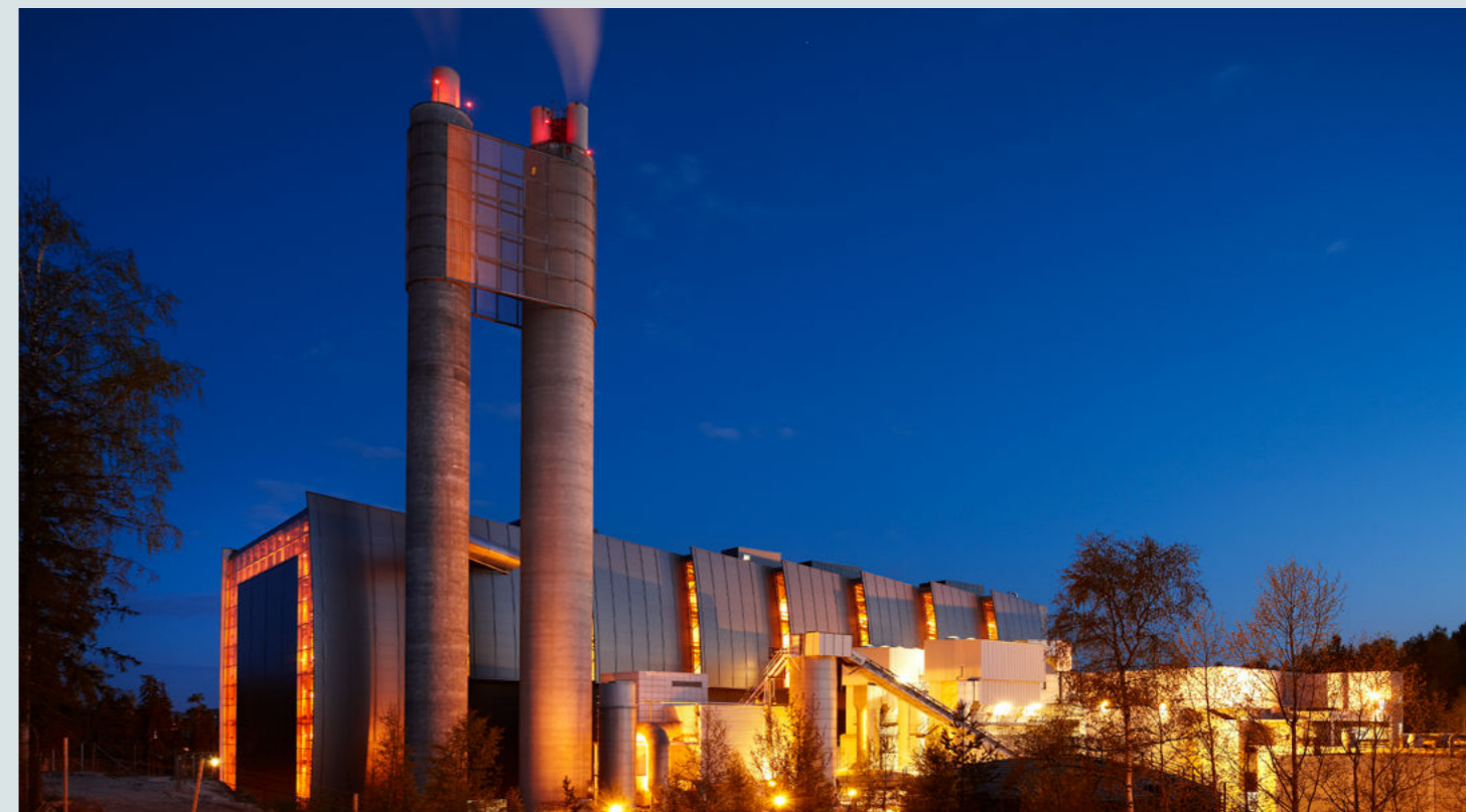
Avfallsanlegget på Klemetsrud. Foto: Morten Brakestad/Hafslund
