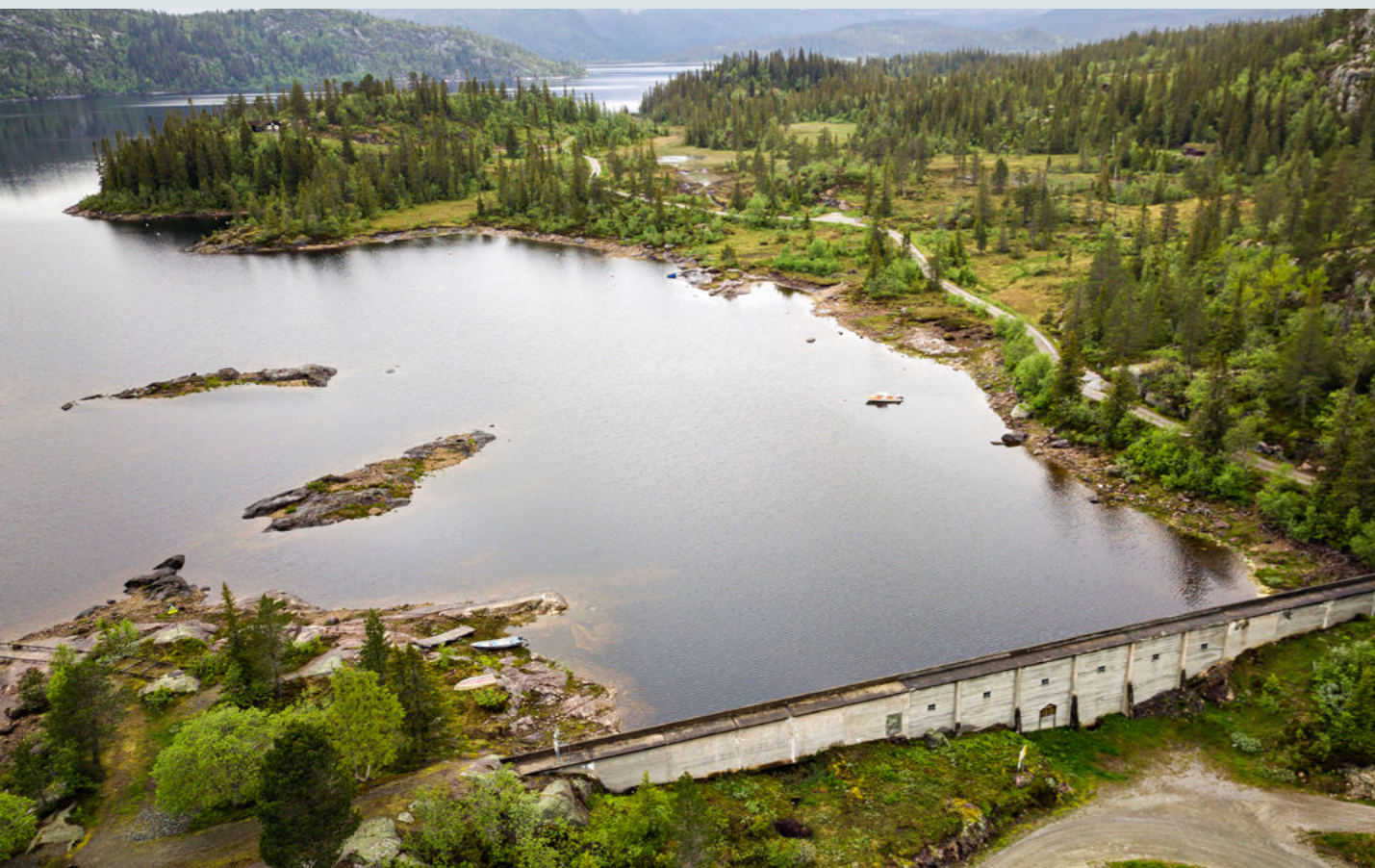
Skjesvatn vannmagasin. Foto: Skagerak Energi.
