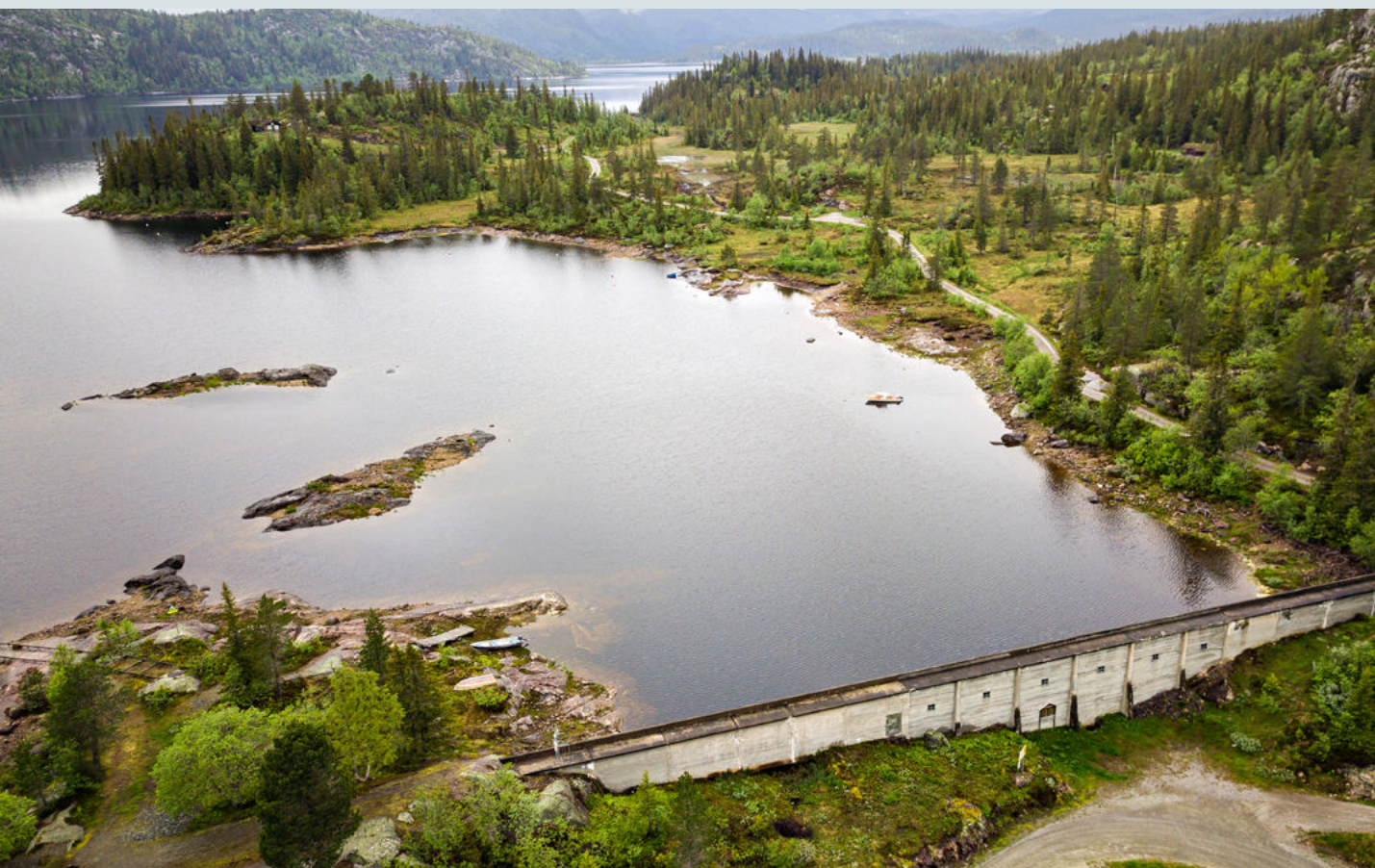
Skjesvatn vannmagasin. Foto: Skagerak Energi.
