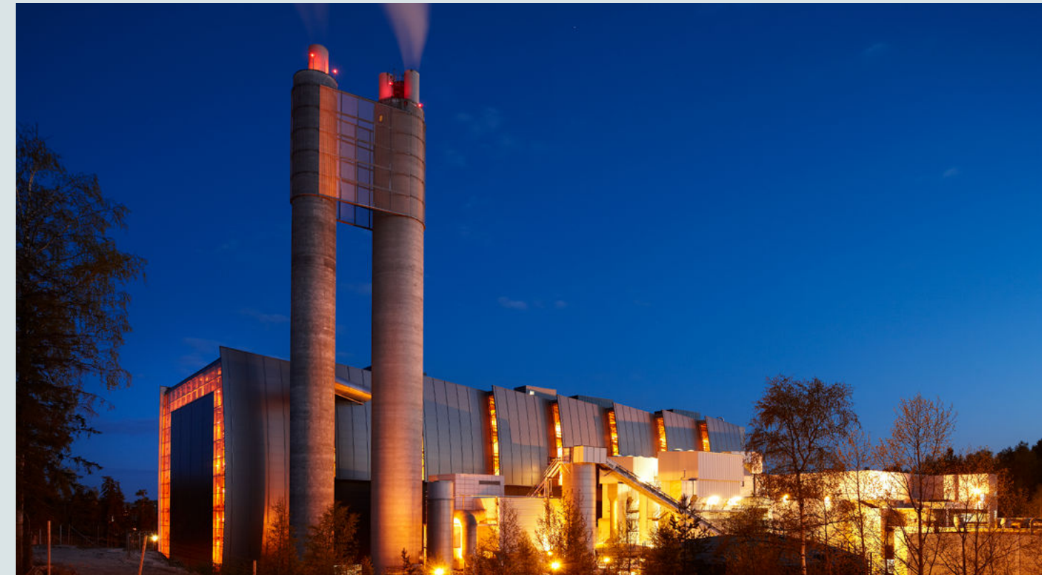
Avfallsanlegget på Klemetsrud. Foto: Morten Brakestad/Hafslund
