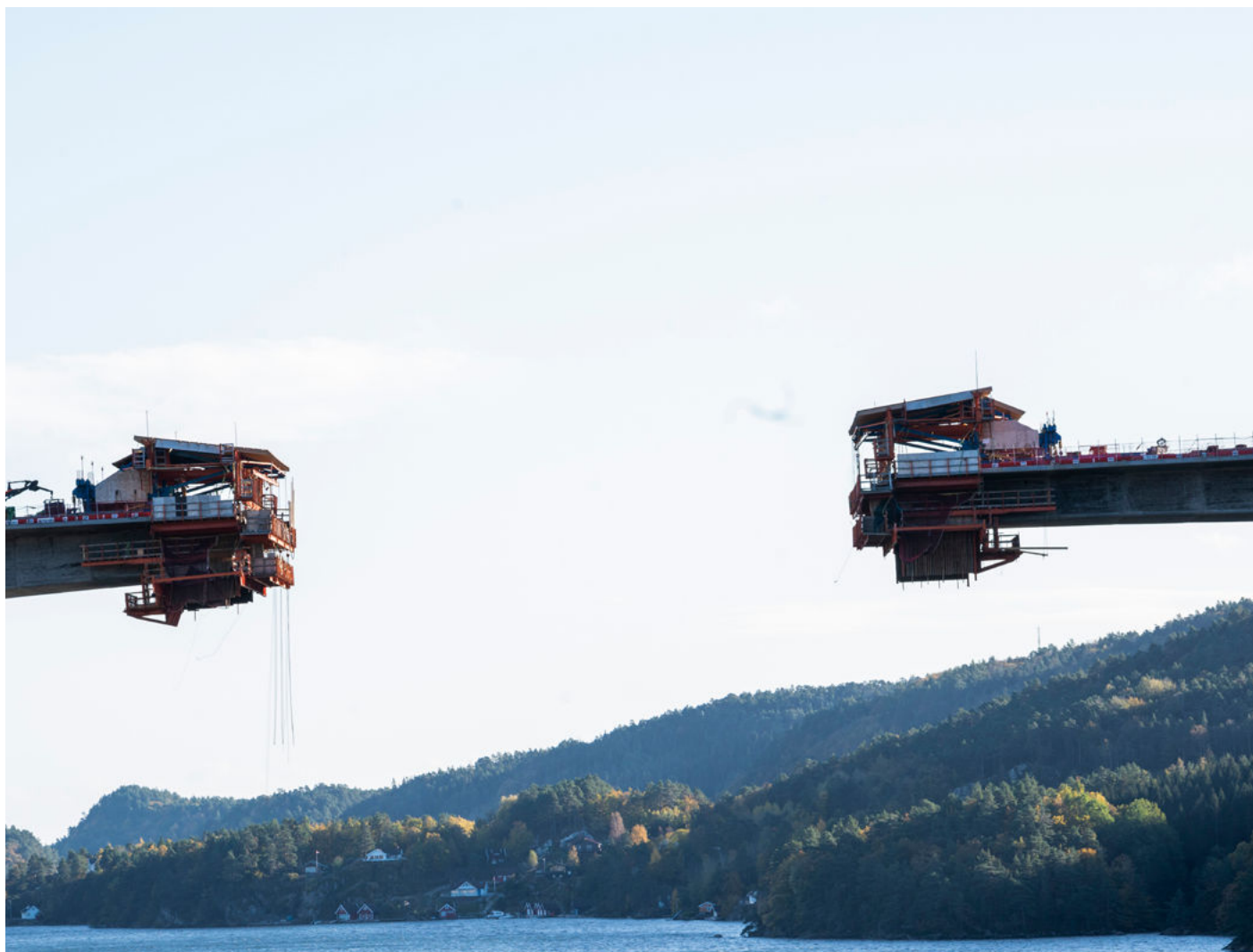
Byggingen av Trysfjordbrua mellom Kristiansand og Mandal. Foto: Liv-Unni Tveitane.
