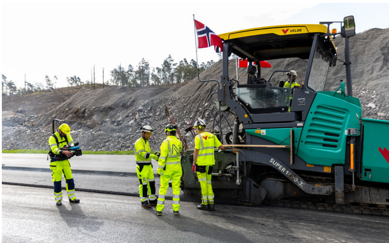
Legging av sirkulær asfalt på E39 Lyngdal øst-Lyngdal vest. Foto: Lisa Ravna Rørmoen, Screen Story/Nye Veier
