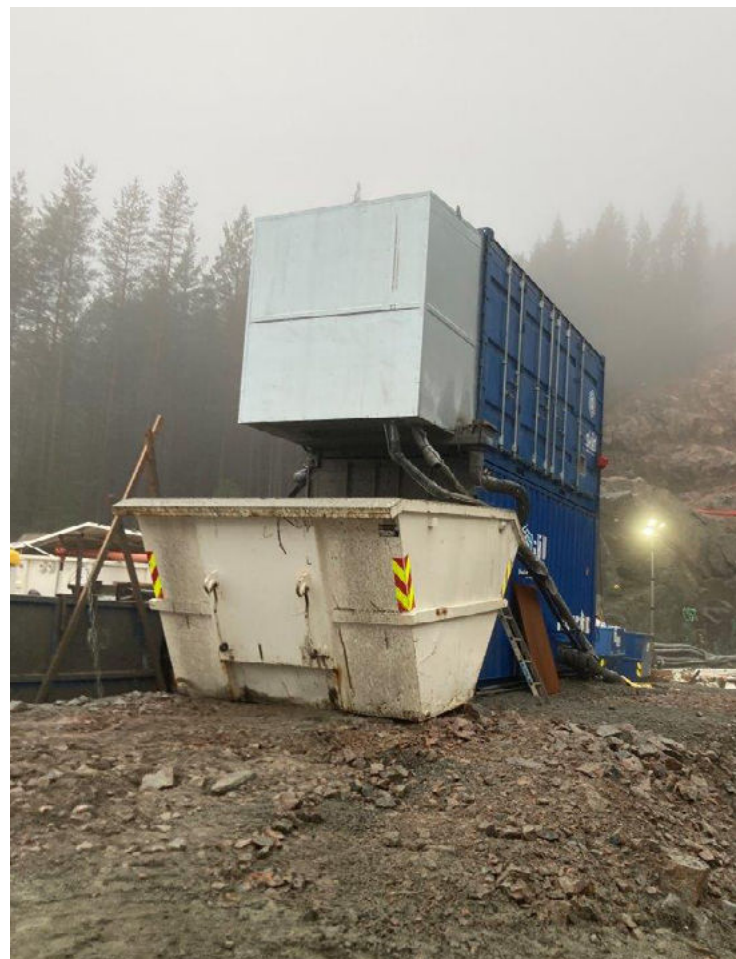
Nye Veier har pilotert gjenbruk av slam på prosjektet E39 Lyngdal øst-Lyngdal vest, og dermed redusert klimagassutslipp fra transport. Foto: Rita T. Bartolomei/Arbeidsfellesskapet Implenía Stangeland (JVIS)
